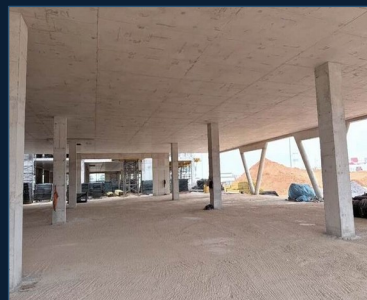
BRICOMA Fès – Dalles post-tensionnées
