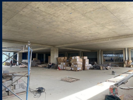
Chantier — Bâtiment industriel
